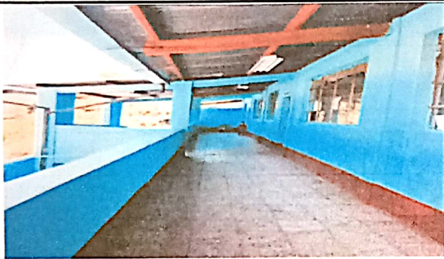
Foto 3: Sustitución de piso en el pasillo del segundo nivel
