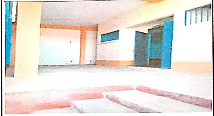
Foto 4: Sustitución de Piso
