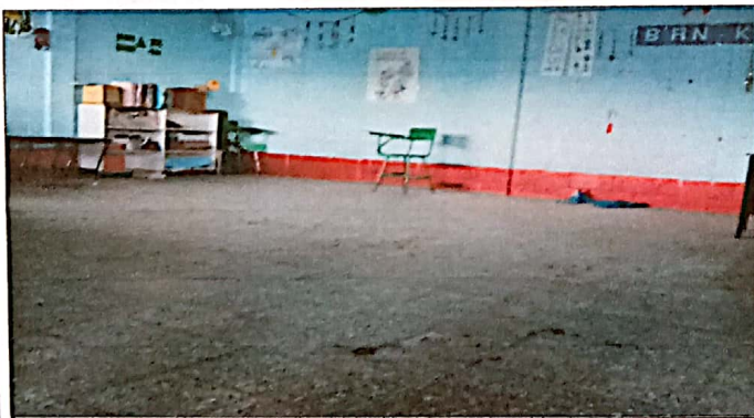
Foto 5: Sustitución de piso en las aulas del primer nivel
