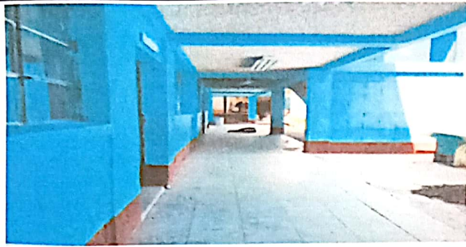
Foto 1: Sustitución de piso en el pasillo primer nivel
